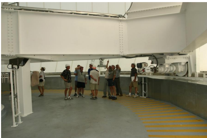
Azimutální, elektromechanický pohon radiolokátoru stanice EBR
